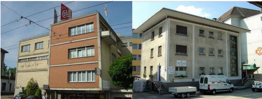
Lagerhalle auf Parzelle Nr. 246, Ansicht von Südwesten
